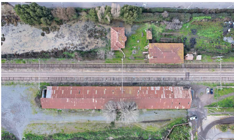
(Fig. 2) Recinto-estación de Tenorio. Registro por Plegma Fotografía.
