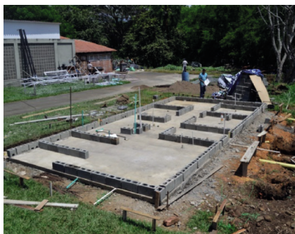
Muros en mampostería estructural
