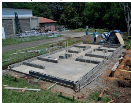
Muros en mampostería estructural
