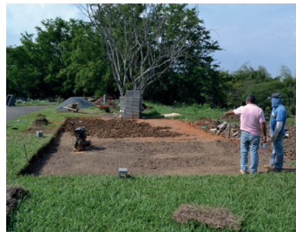
Replanteo de ejes. Instalaciones
