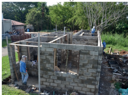
Fundición de viga de amarre
