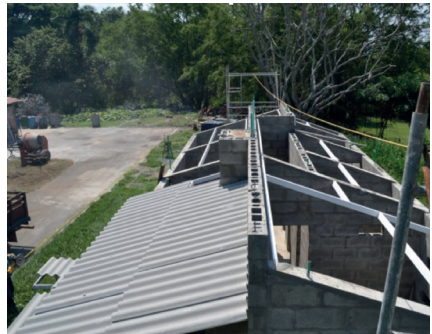
Techado con tejas tipo sandwich
