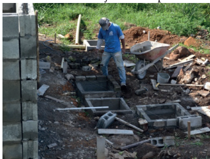
Fundición de cajas de inspección
