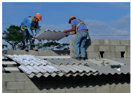
Techado con tejas tipo sandwich
