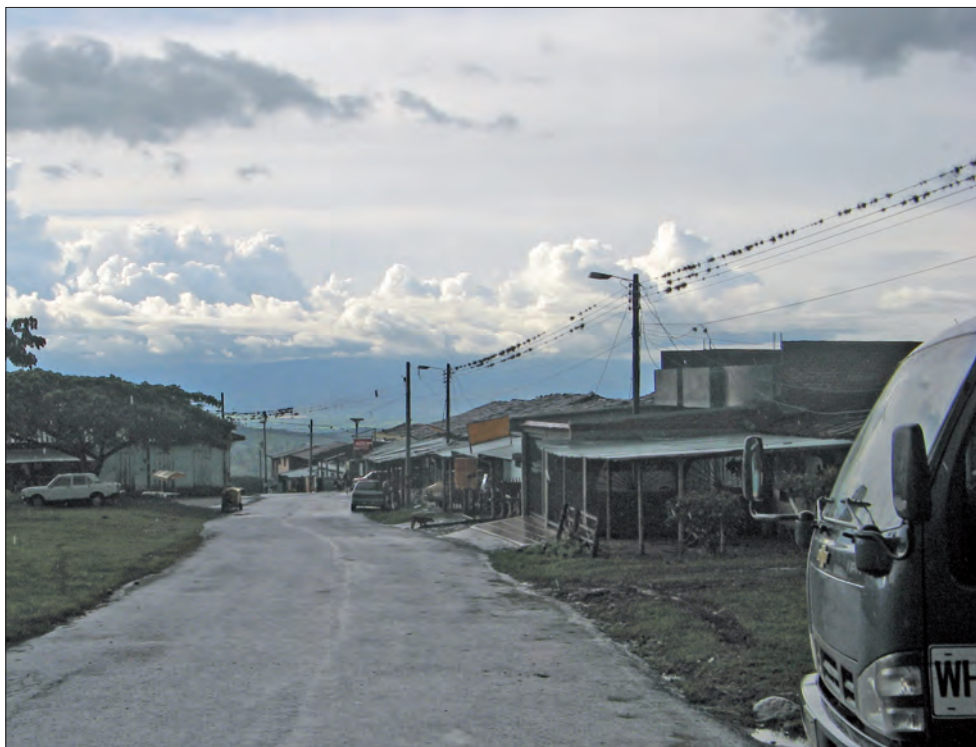
Foto 32 Vías secundarias pavimentadas en mediano o buen estado
