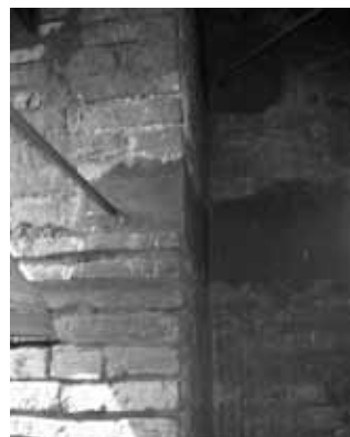
Foto 34. Torre de San Francisco, Cali. Refuerzos estructurales.
