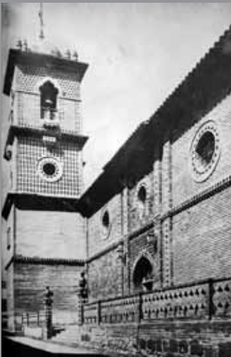
Foto 36. Convento de San Francisco, Cali. Las intervenciones de Acuna.
