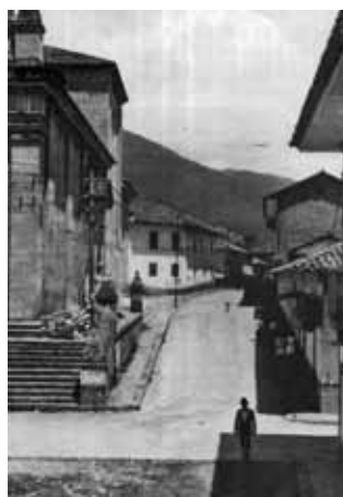
Foto 25. Convento de San Francisco, Cali. Fachada claustro nororiental.
