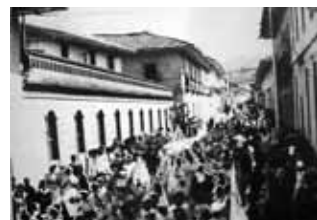
Foto 21. Convento de San Francisco, Cali. Fachada claustro noroccidental.
