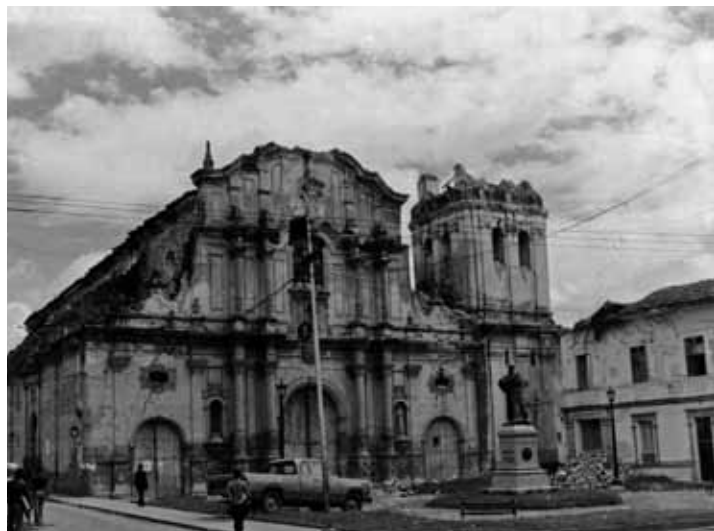
Foto 23. Estado del templo y de la torre campanario luego del terremoto.
