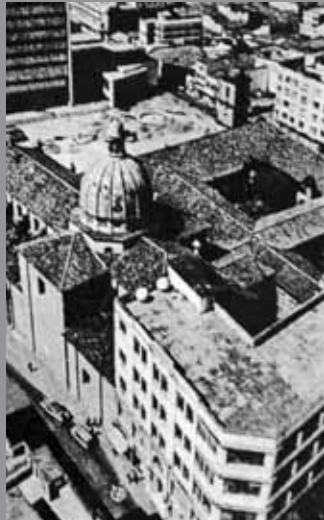
Foto 37. Convento de San Francisco, Cali. Edificio esquina calle 10 con carrera 5ta.
