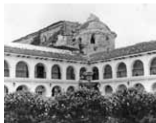
Foto 24. Estado de la cúpula luego del terremoto.
