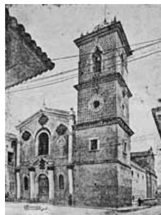
Foto 29. Convento de San Francisco, Cali. Capilla conventual antes de 1925.
