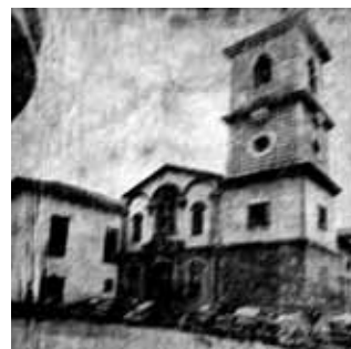
Foto 39. Convento de San Francisco, Cali. Atrio sur occidente antes de la ampliación de la calle 9a..
