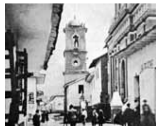
Foto 28. Conjunto San Francisco, Cali. Capilla conventual 1915.
