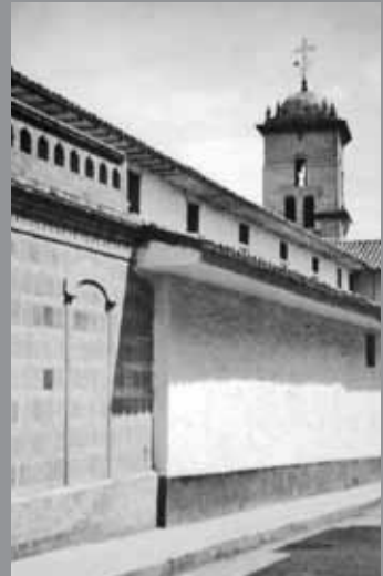
Foto 38. Convento de San Francisco, Cali. Antiguo paramento calle 9a.
